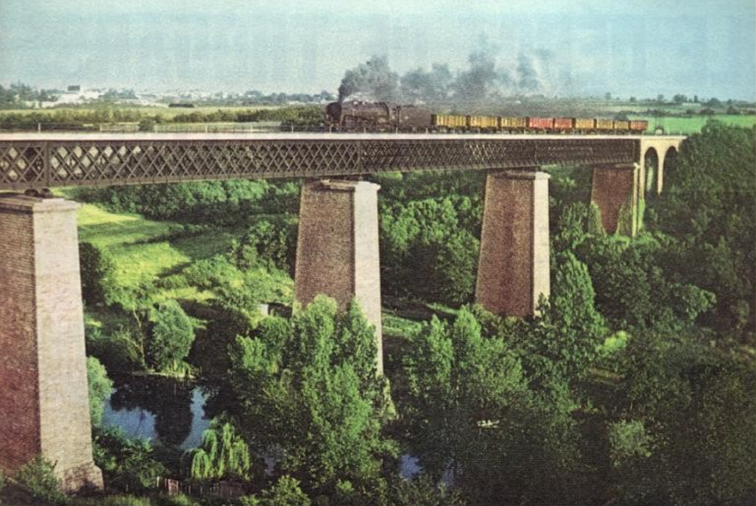
Une 141 R, en tête d'un train de marchandises sur le viaduc de Thouars.
